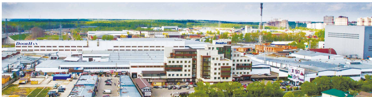
РОССИЯ, МОСКОВСКАЯ ОБЛАСТЬ. Главный производственный и распределительный центр ГК DoorHan
